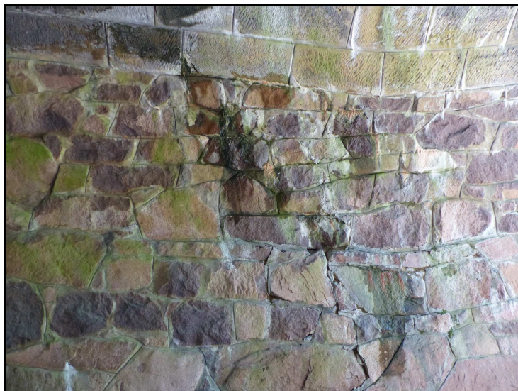
Foto č. 4 Opěra O 01 Svislá trhlina po spárách ve vzdálenosti 3,00 m zleva s průsaky
