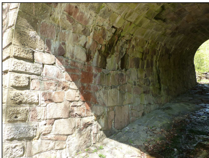
Foto č. 2 K 01 Průsaku vody a výluhy pojiva nad opěrou O 02
