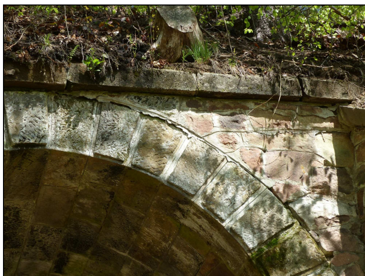
Foto č. 3 K 01 čelní zeď vlevo nad O 01 Vodorovná trhlina + vytlačení čelní zdi u vrcholu klenby
