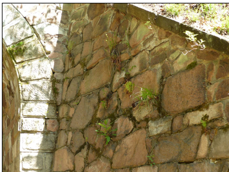
Foto č. 5 Křídlo opěry O 01 vlevo Stupňovitá trhlina po spárách + vysunutí zdiva.
